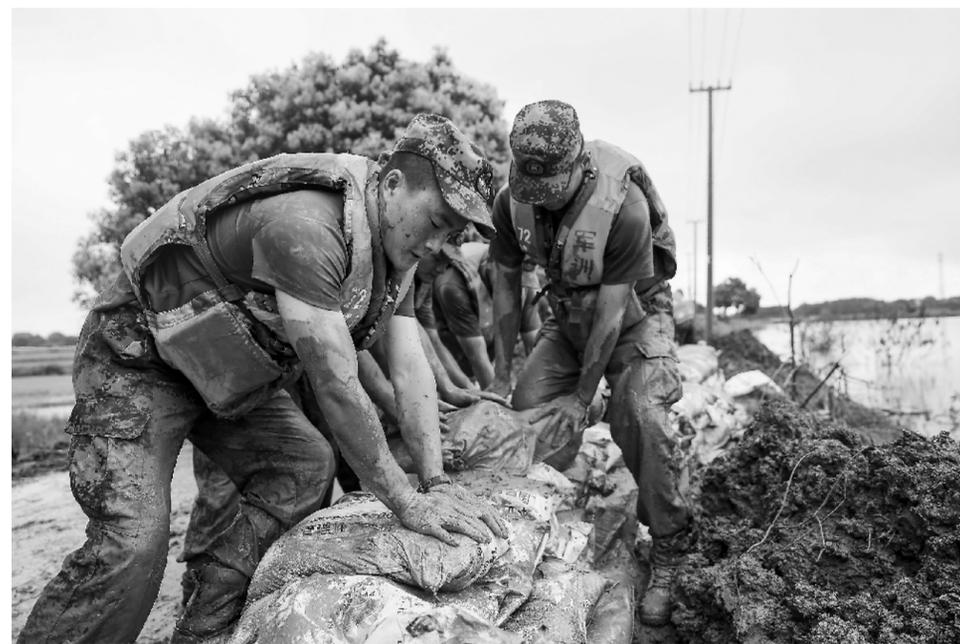
在安徽铜陵抗洪一线,第72集团军某旅官兵全力投入战斗。为防止子堤被洪水冲垮,官兵们用力压实沙袋,确保防汛堤坝牢固可靠。
